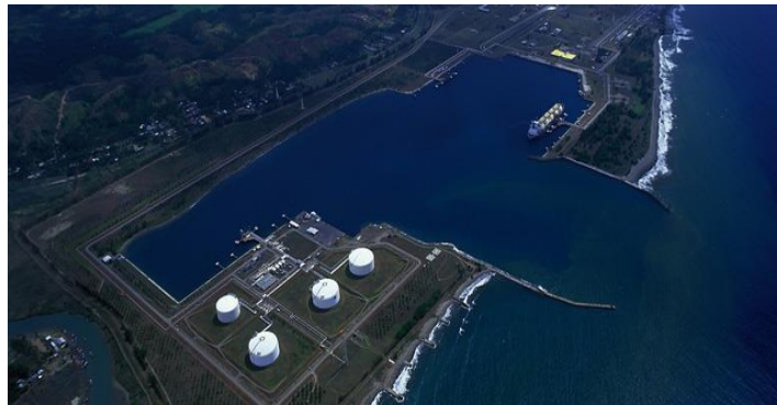
Fig. 1 Arun LNG terminal site
